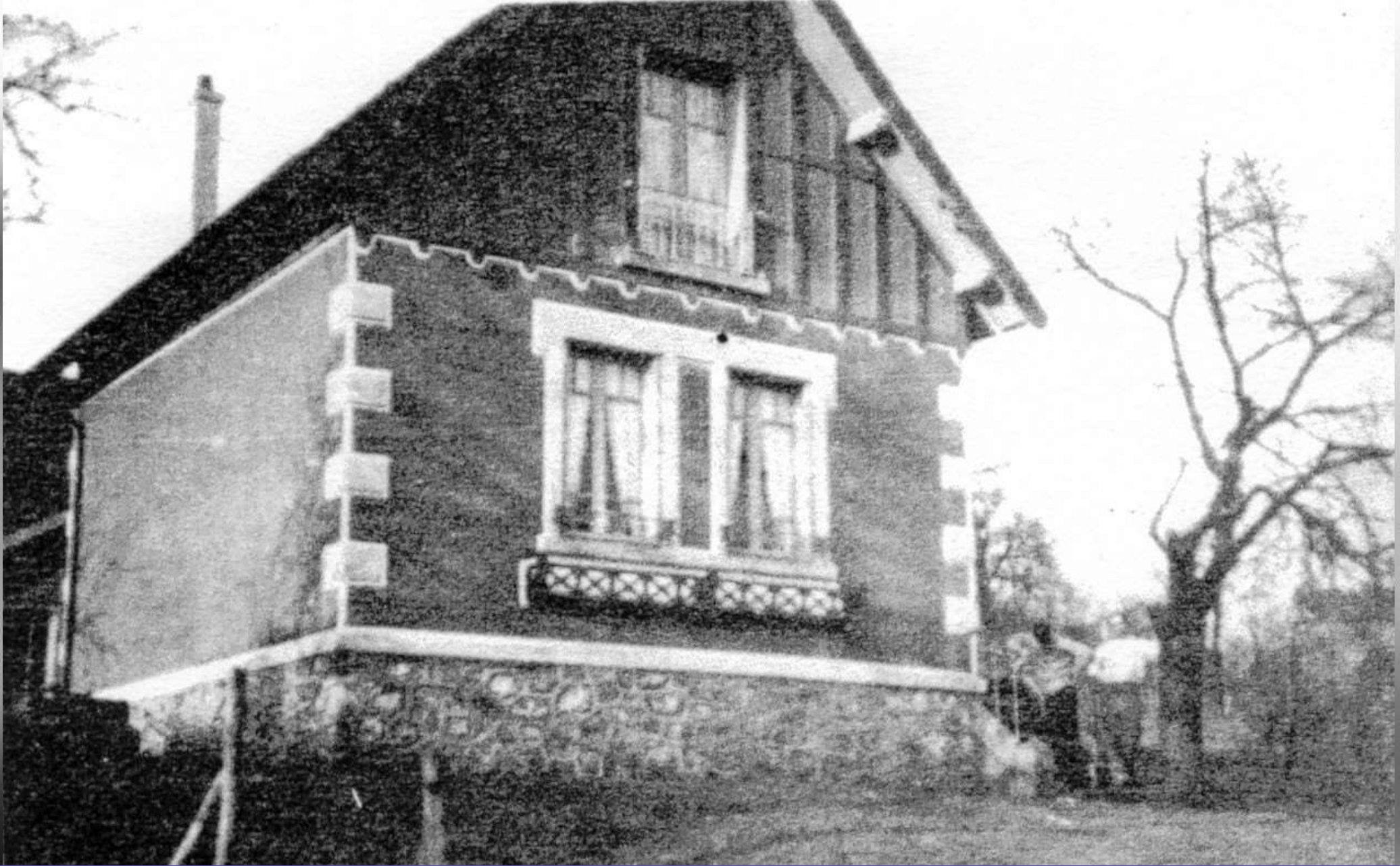
Construction de la Maison au 26 rue Anatole France
